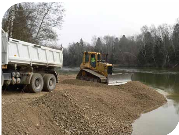
Laichplatzbau durch Kieszugabe im Lech bei Scheuring Anfang 2009. Eine gängige Methode zur Wiederherstellung von Kieslaichplätzen.
