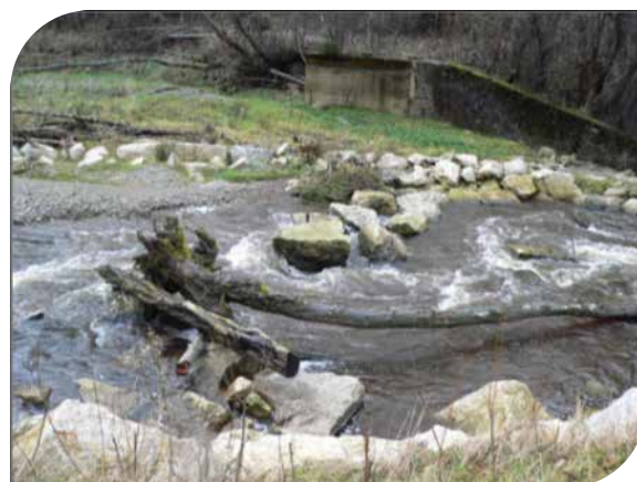
Raue Rampe nach dem Umbau. Blick auf den ehemaligen Staubereich: Wo früher Schlamm­bänke waren, befinden sich heute Kiesbänke.
