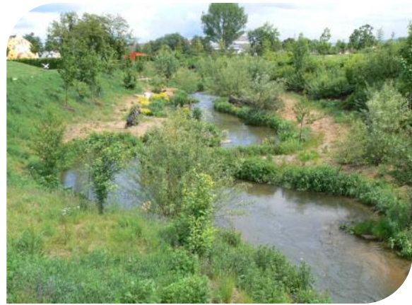
Naturnaher Verlauf des neu geschaffenen Umgehungsgewässers.
