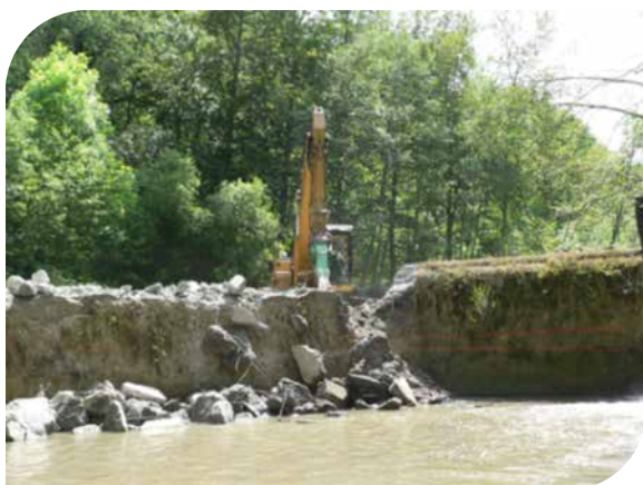
Abriss des HSM-Wehrs an der Peitnach.
