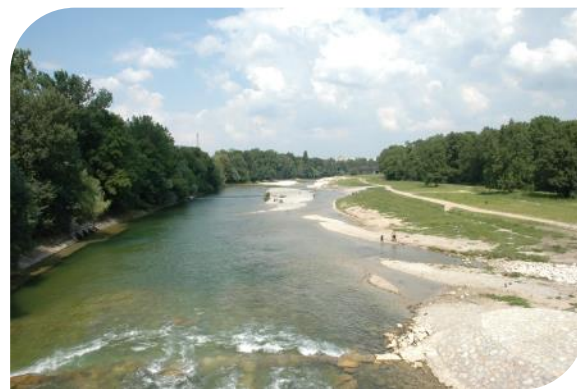
Das aufgeweitete strukturreiche Gewässerbett nach Durchführung der naturnahen Flussbaumaßnahmen.
